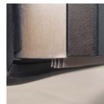
uszczelka wargowa, przyłga z uszczelką
